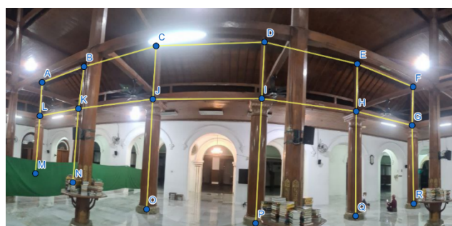
Gambar 7. Tiang dan Pilar Pada Masjid
